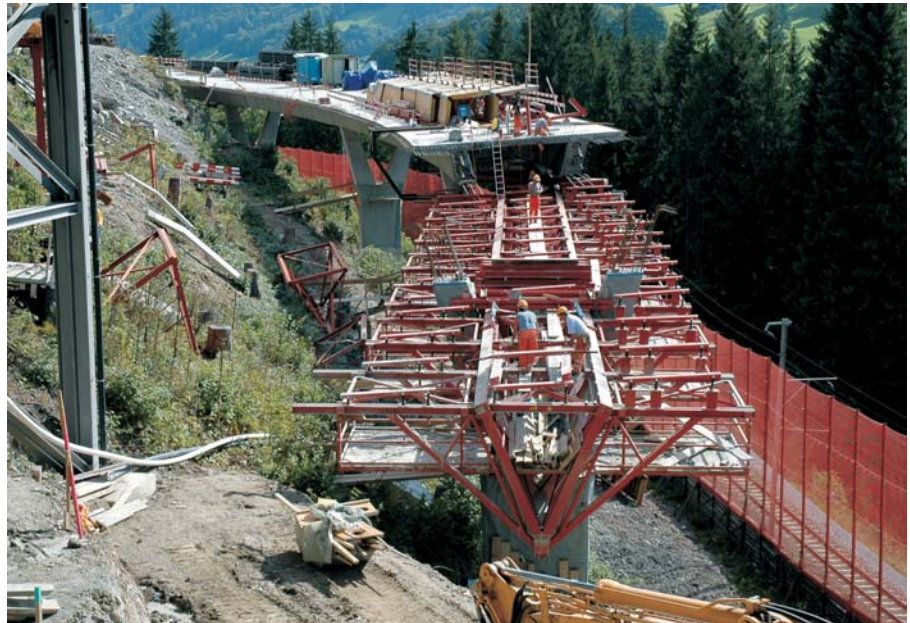
Die Hexentobelbrücke kurz vor der Fertigstellung. Das letzte Brückenfeld wird noch diesen Herbst betoniert. Danach erfolgt die Verschiebung des Lehrgerüsts für den Bau der anschliessenden Marchtobelbrücke im Frühjahr 2006.
