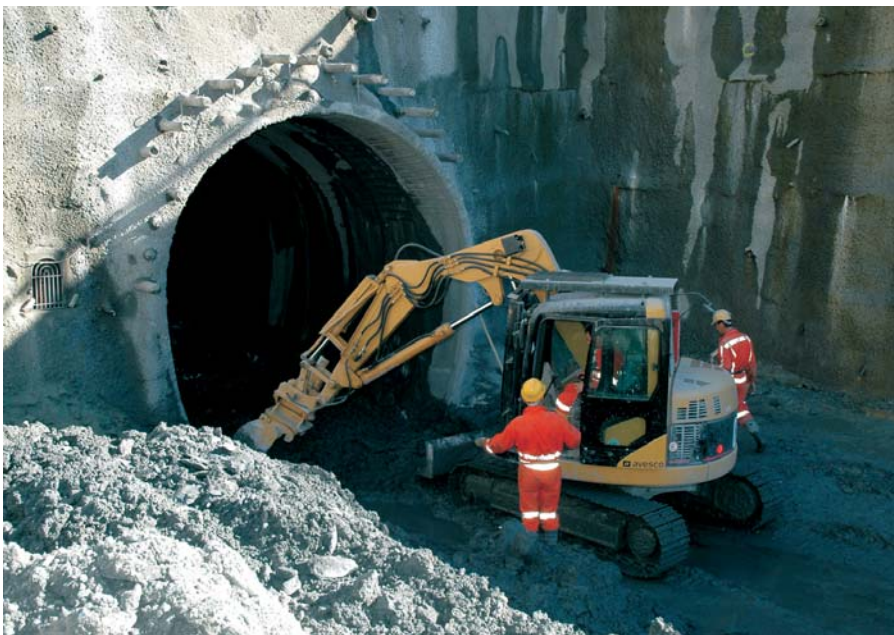
Die ersten Meter Ausbruch im Lockermaterial für den Sicherheitsstollen
