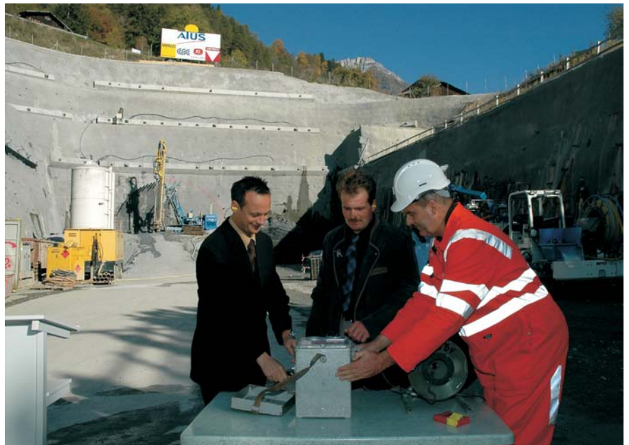
Der tiefe Voreinschnitt beim Portalbereich West ist bereit für die erste Sprengung.
