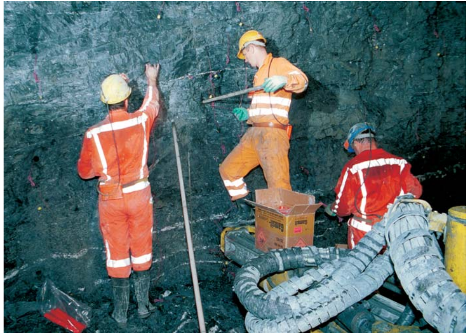
Laden der Bohrlöcher an der Tunnelbrust mit Sprengstoff.
