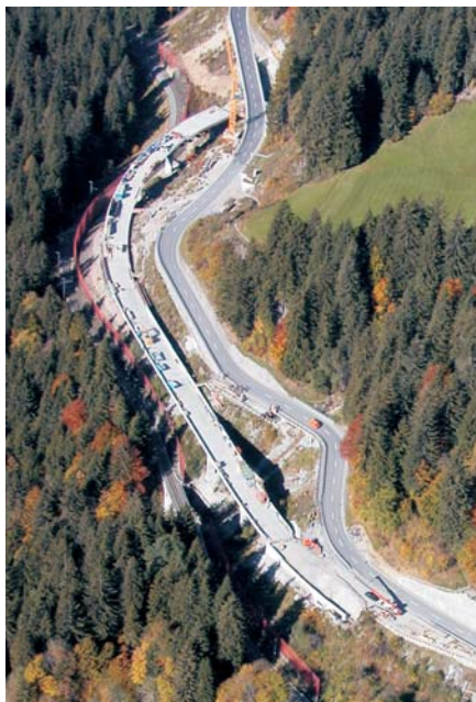
Die Hexentobelbrücke, eingeklemmt zwischen dem Trasse der RhB und der Prätigauerstrasse.
